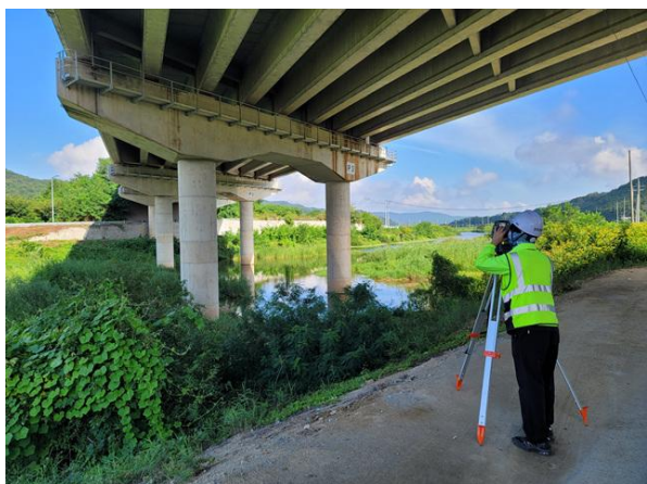
광파기를 이용한 측량 작업
